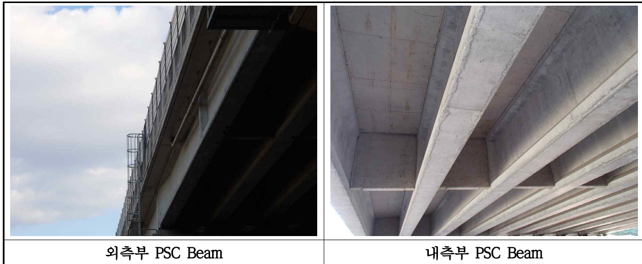
【사진 3.2.3】 PSC Beam 전경(대구)
