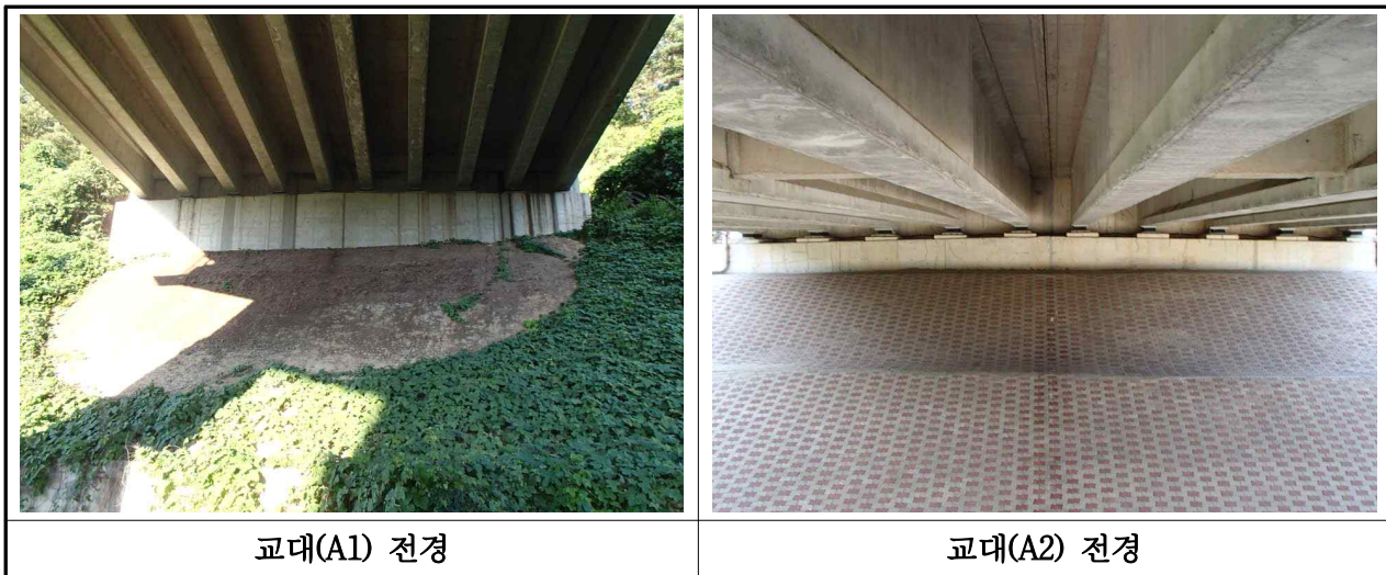
【사진 3.2.7】 교대 전경(대구)
