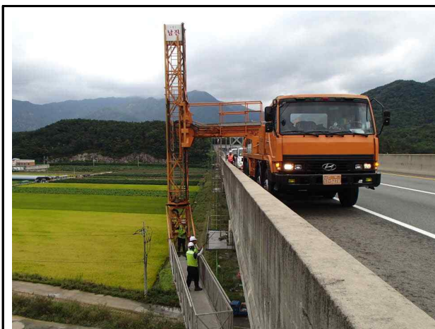
교량점검차를 이용한 조사
