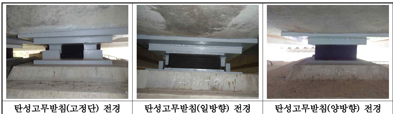
【사진 3.2.12】 교량받침 전경(대구)
