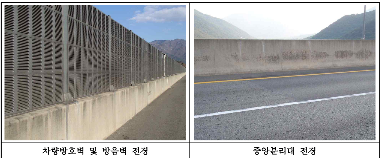
【사진 3.2.21】 방호벽 및 중앙분리대 전경(대구)
