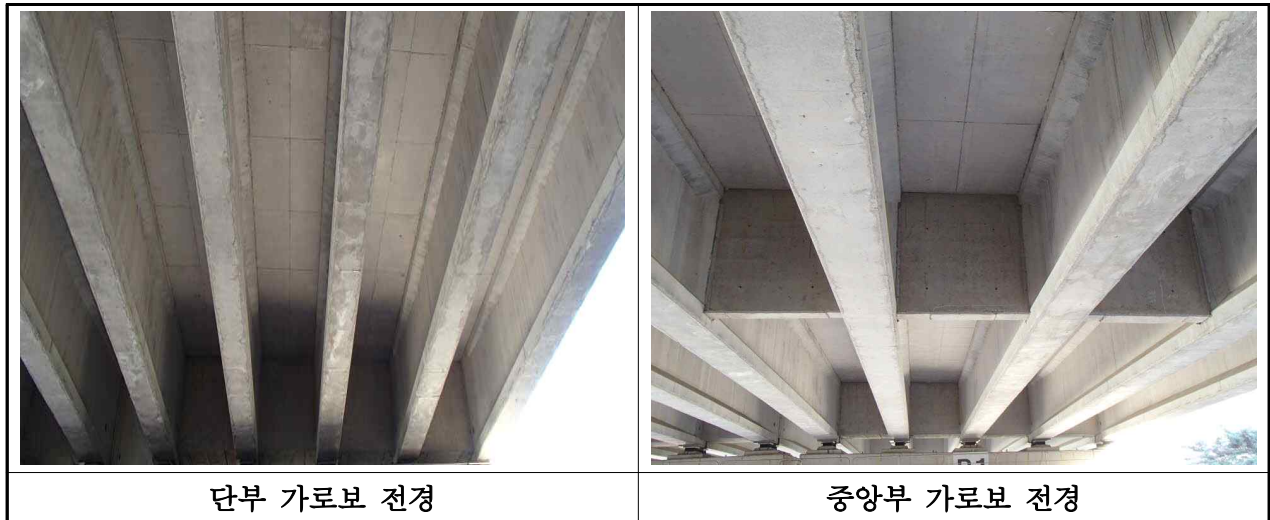
【사진 3.3.5】 가로보 전경(부산)
