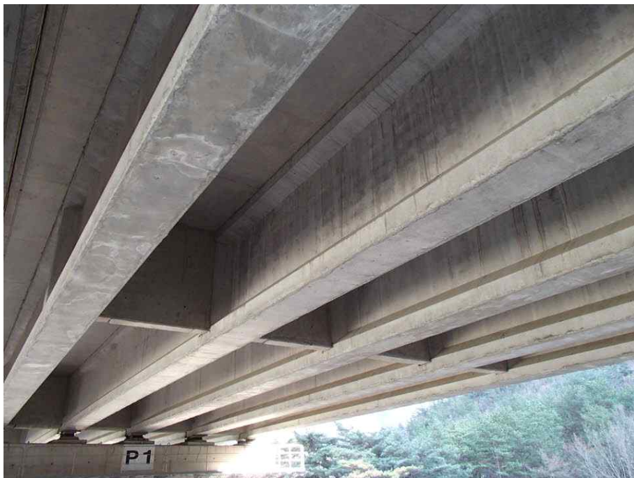
PSC I BEAM 전경
