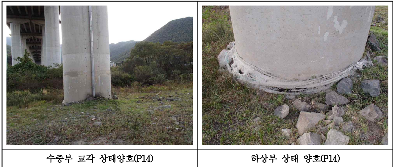
【사진 3.2.11】 교각 수중부 조사 현황(대구)
