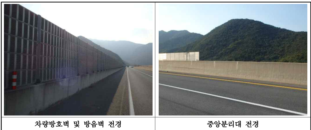
【사진 3.3.21】 방호벽 및 중앙분리대 전경(부산)
