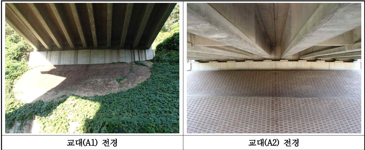
【사진 3.3.7】 교대 전경(부산)
