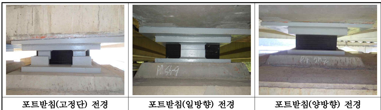
【사진 3.3.12】 교량받침 전경(부산)
