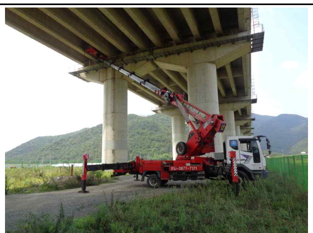
고소점검차를 이용한 조사
