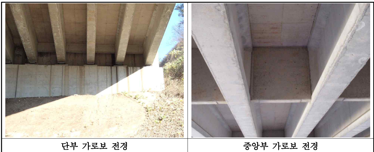
【사진 3.2.5】 가로보 전경(대구)
