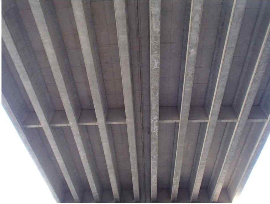
바닥판하면 및 PSC I BEAM 전경
