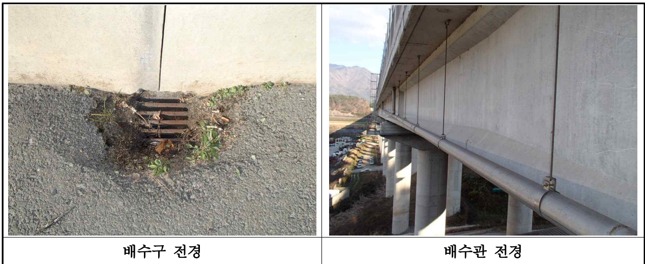
【사진 3.2.19】 배수구 및 배수관 전경(대구)
