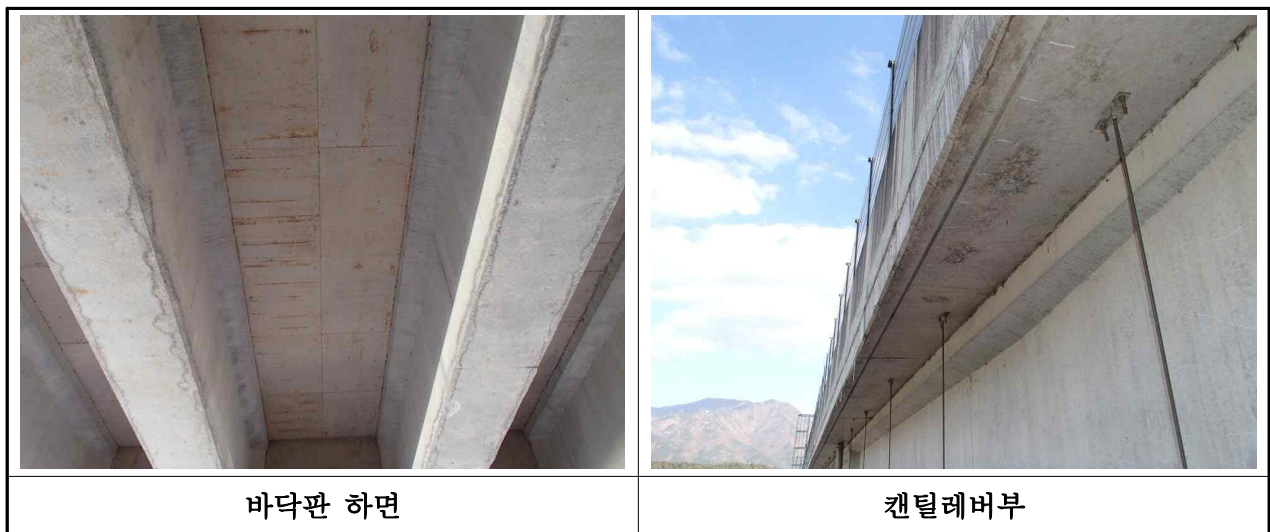
【사진 3.2.1】 바닥판 전경(대구)
