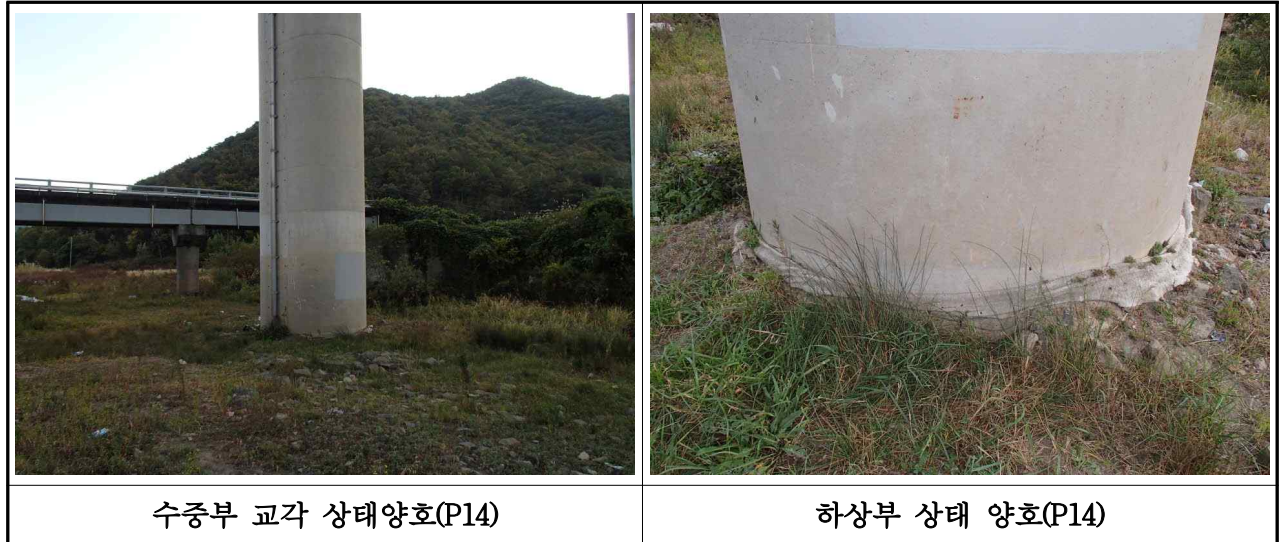
【사진 3.3.11】 교각 수중부 조사 현황(부산)
