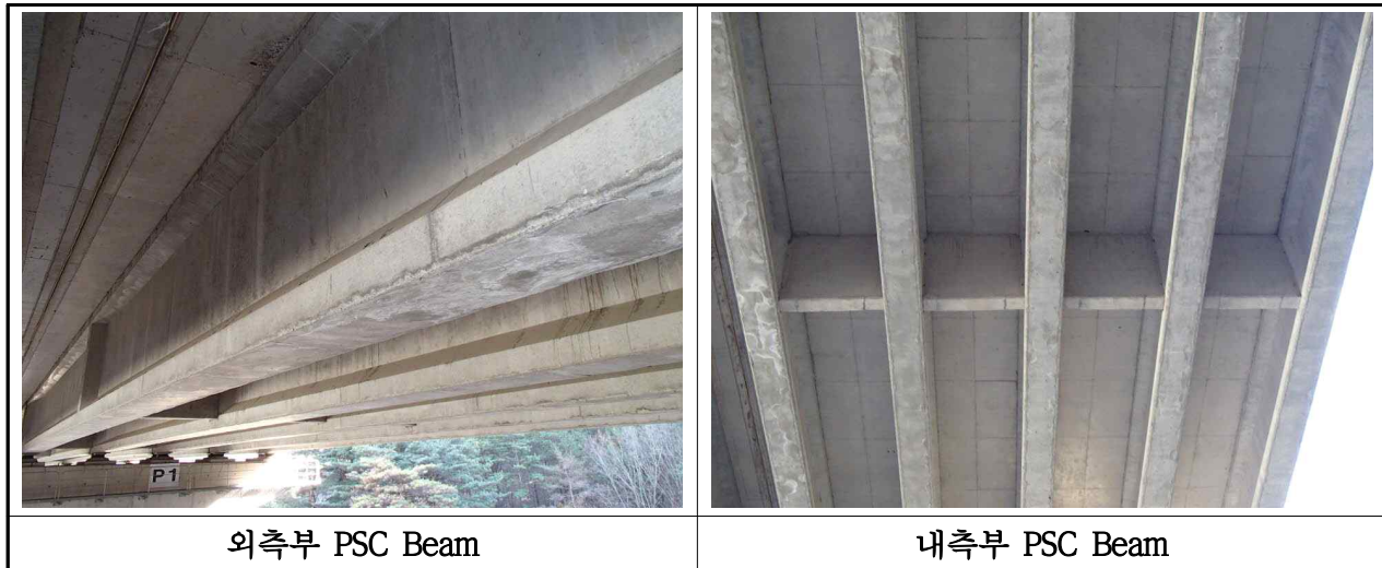
【사진 3.3.3】 PSC Beam 전경(부산)
