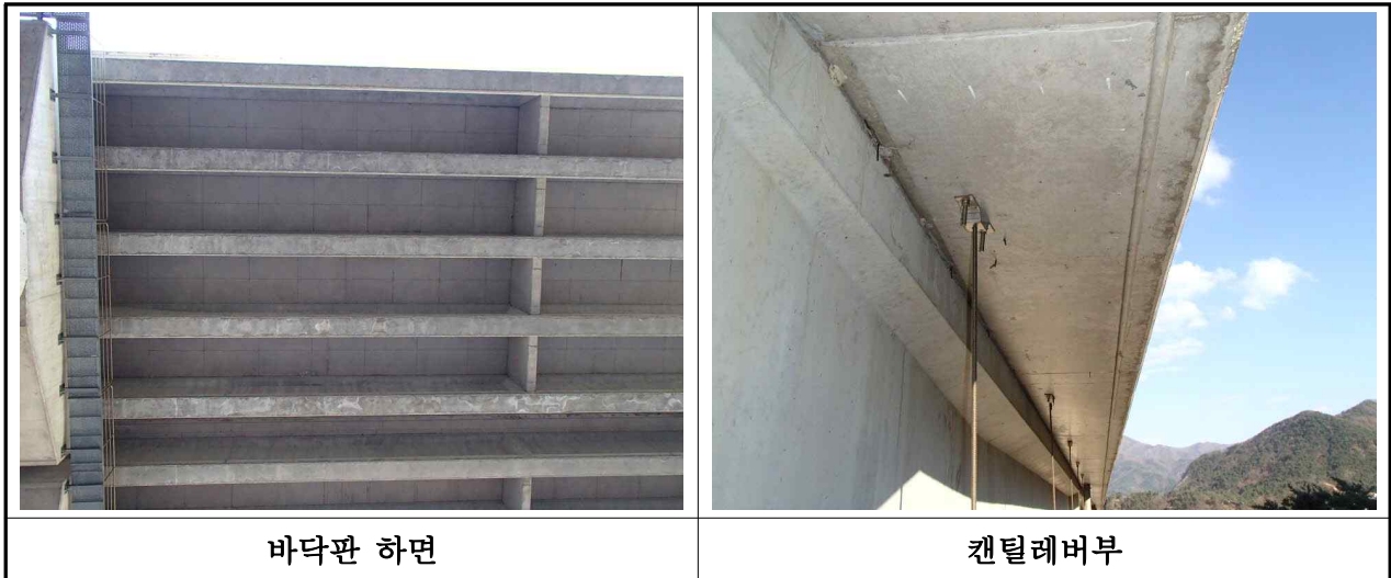
【사진 3.3.1】 바닥판 전경(부산)
